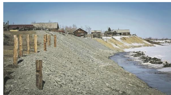
Завершено строительство объекта «Берегоукрепительные работы на реке Вилюй в районе села Верхневилуйск»
